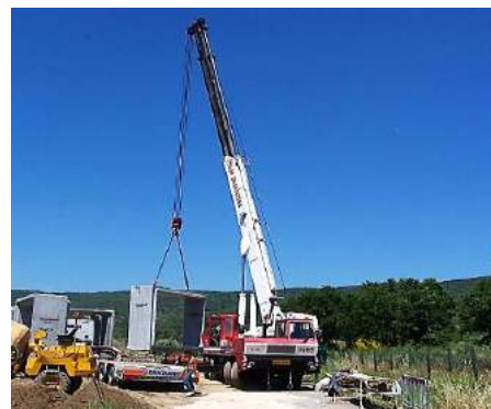
arrivo scatolari sul cantiere
