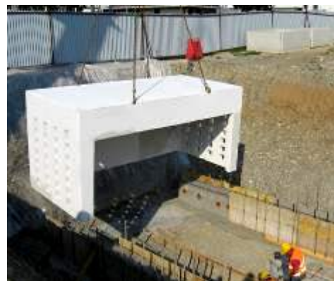
posa elemento di testata SIS
