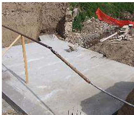
realizzazione platea di posa scatolari
