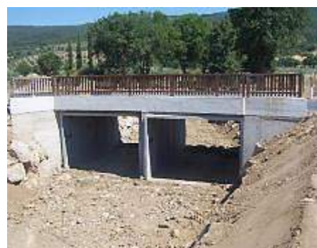
lavoro finito e ripristino viabilità
