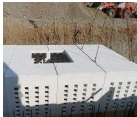
fasi di montaggio
